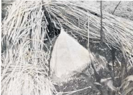
④ 風表にわら束で防風とする。硫酸紙2ツ切りとして一方を貼り、1本の支柱で支え、前方は土中に埋める
